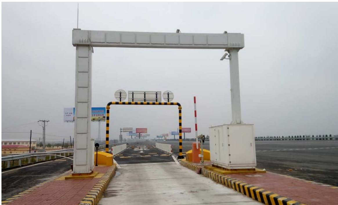
图 4 绿色通道检查系统全景图
