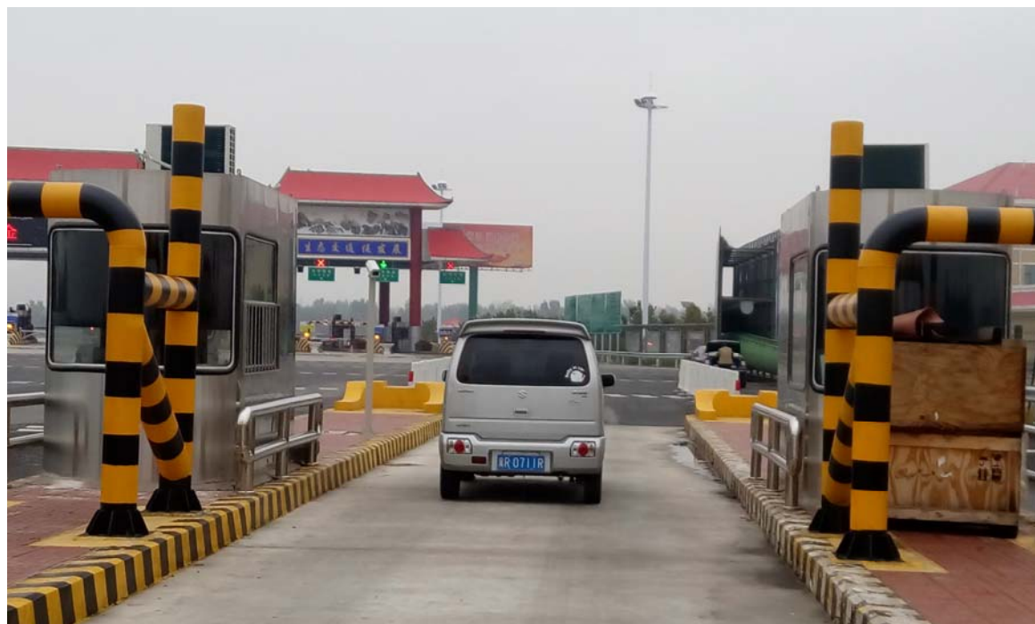
图 8 绿色通道检查系统北侧现状图
