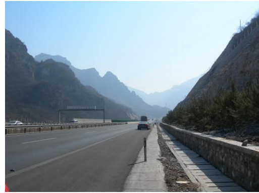
重力式挡土墙防护
