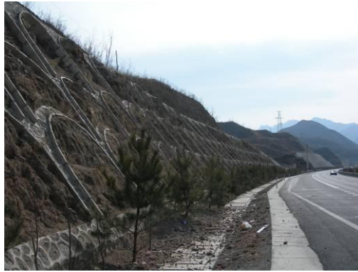
混凝土预制块镶边防护
