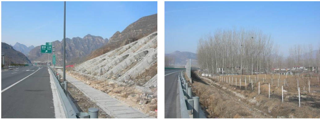
路基排水边沟
